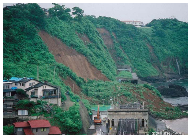
写真－2 柏崎市青海川 JR 信越本線埋没状況 平成 19 年 7 月 16 日午前 10 時 13 分、新潟県中越沖の深さ 17km を震源とする、M6.8 の地震が発生し、新潟県柏崎市、長岡市、刈羽村、長野県飯綱町で震度 6 強
