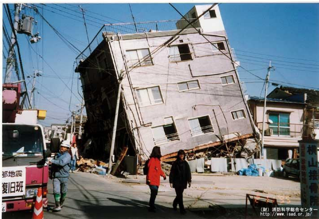
地震による住家被害の様子（ＪＲ新長田駅からＪＲ鷹取駅にかけて） 阪神淡路大震災（1995.1.17 震度7 M7.3） （財団法人消防科学総合センター提供）
